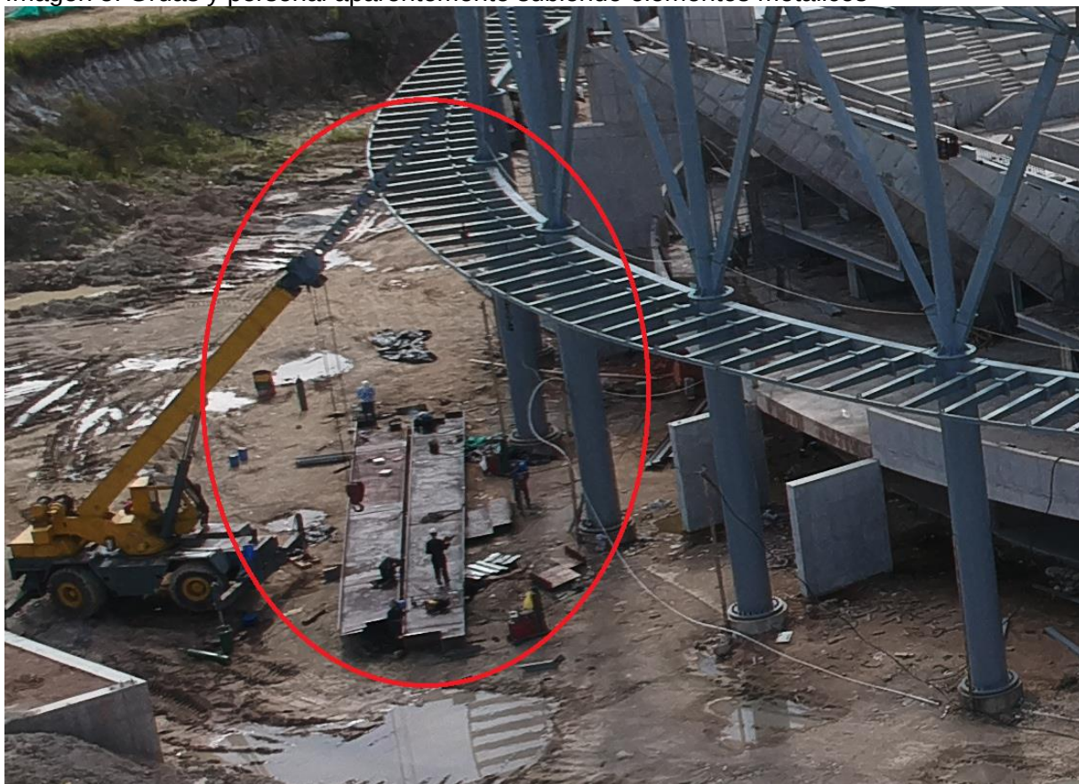
Imagen 5. Grúas y personal aparentemente subiendo elementos metálicos
