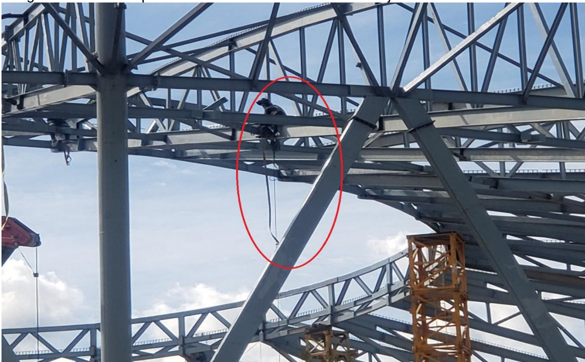
Imagen 4. Personal aparentemente en actividades de trabajo en altura
